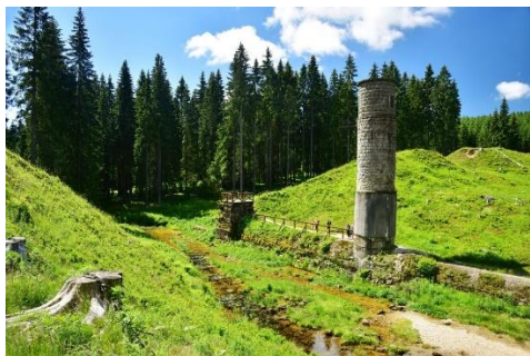
Bílá Desná dam
